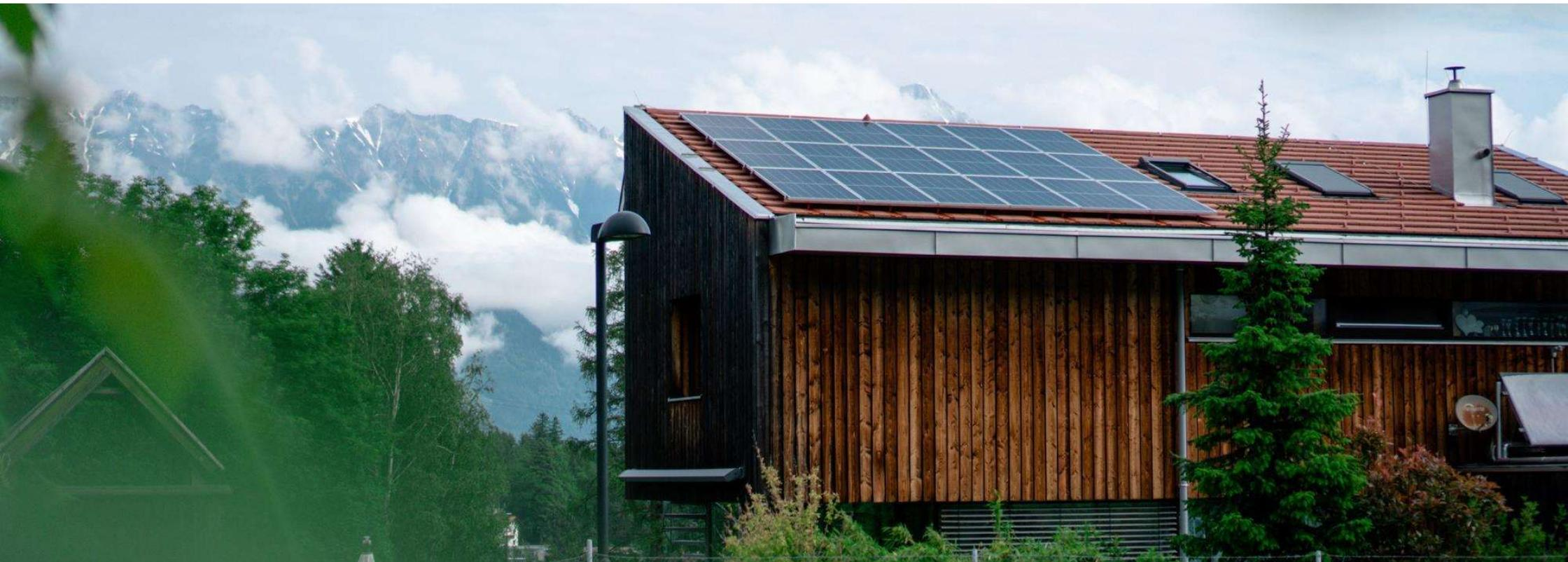
Mit einer 2,5 kWp (15m<sup>2</sup>) großen *Photovoltaikanlage* kann der *Strombedarf* für eine jährliche Fahrleistung von **12.500 km** erzeugt werden.
